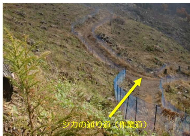
写真12 ブロックディフェンスの実施状況
