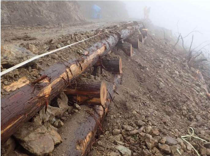
写真8 路面補強工の実施状況
