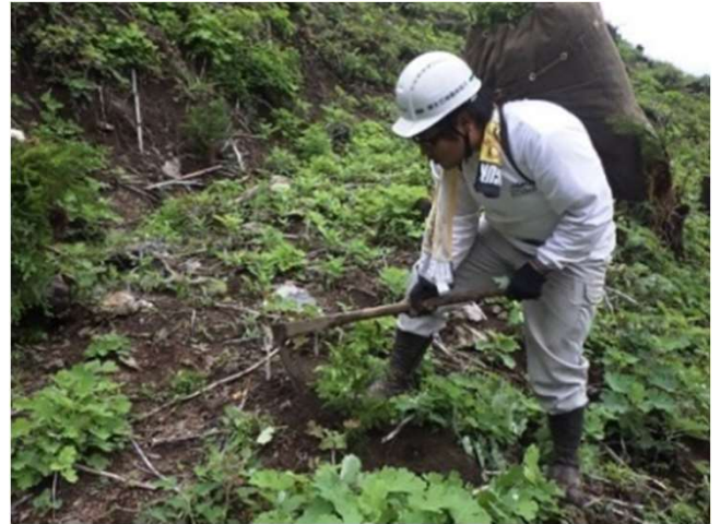
写真7 苗木の植栽作業
