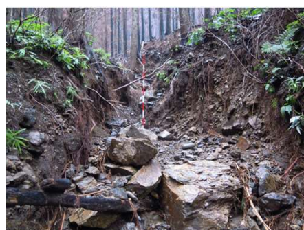
写真4 洗堀被害の状況
